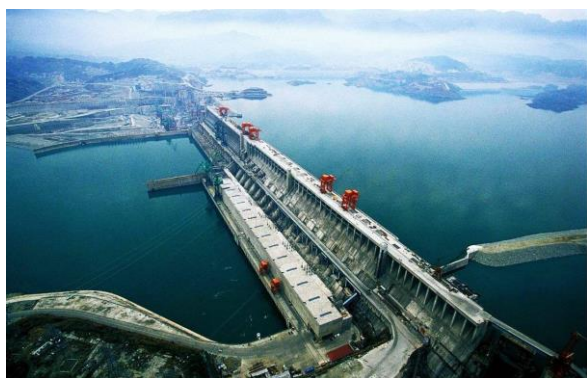
Obrázek 1: hydroelektrárna Tří soutěsky.
